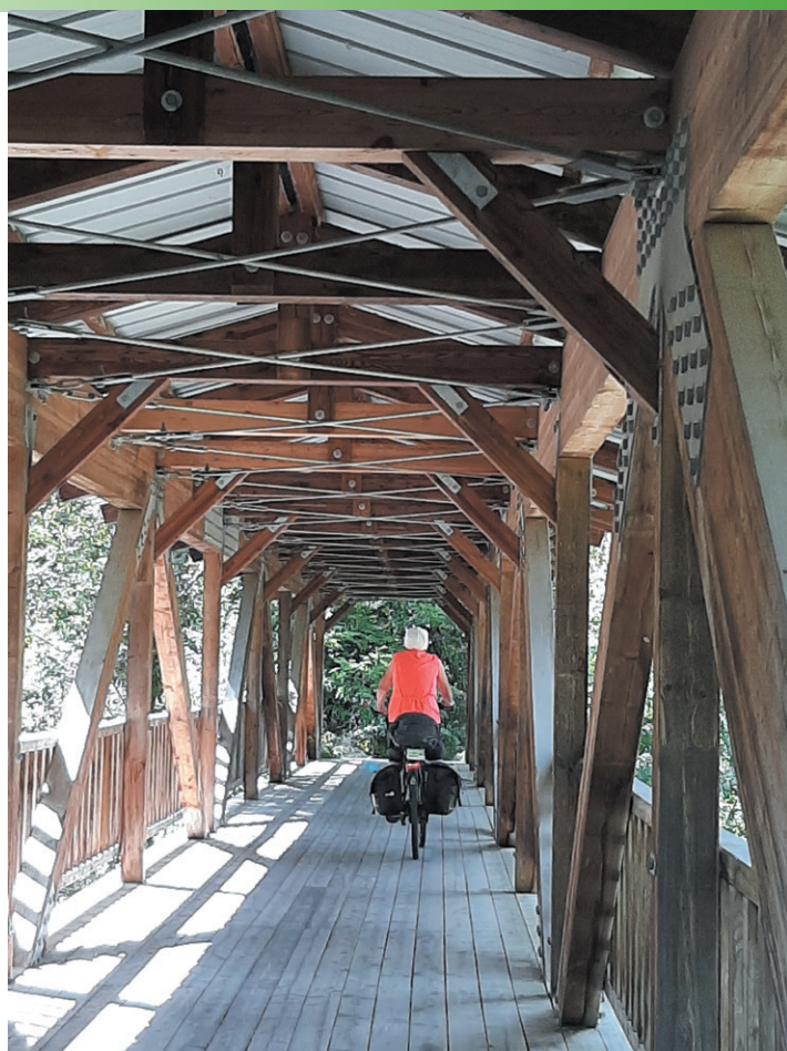
▲ Pont couvert, Les Estrets (Alpes de Haute Provence).
