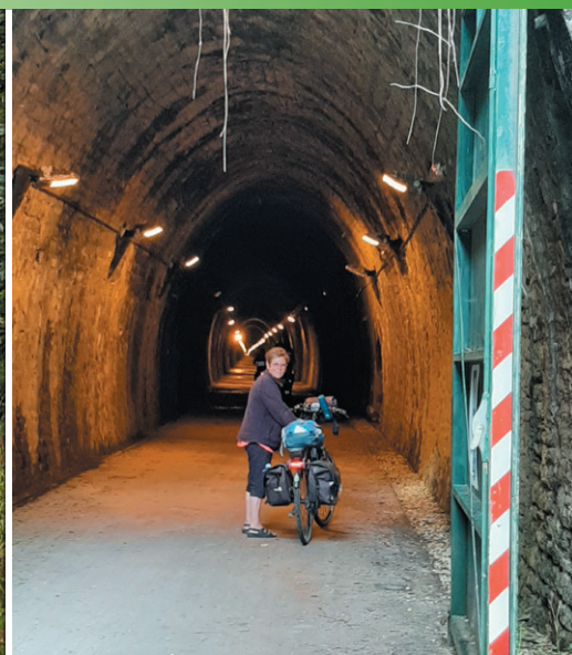
▲ Le plus long tunnel cycliste d'Europe.
