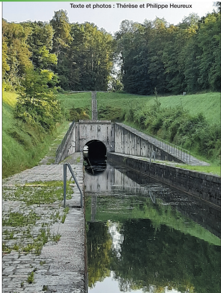
▲ Tunnel de Savoyeux (Haute-Saône).
