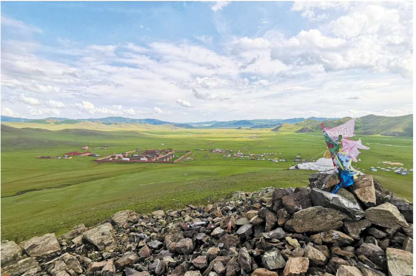
Le temple d'Amarbayasgalant vu depuis les hauteurs du mont Buren-Khan.
